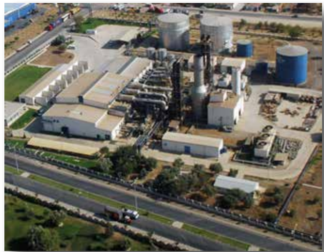
MOSB Enerji Santrali
